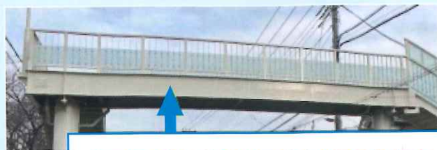
歩道橋の桁面部分に愛称を表示できます
