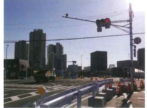
①国道 16 号柏儀式殿前右折信号機設置↑
