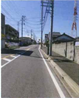
④県道 278 号 ←歩道拡幅・段差解消
